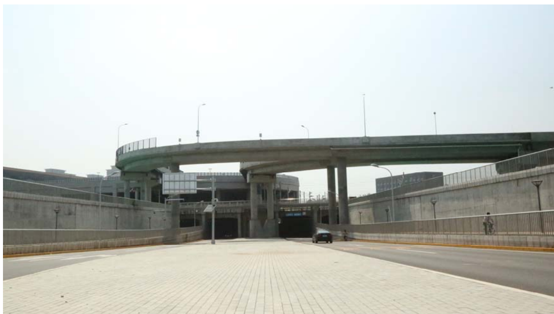
姚家园北街已建成通车段（下穿铁路段）
