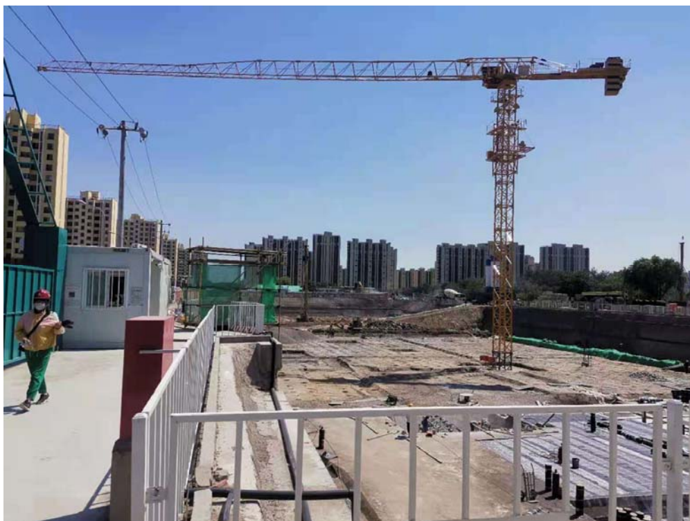
A 座教学楼、风雨操场-现场整体施工照片
