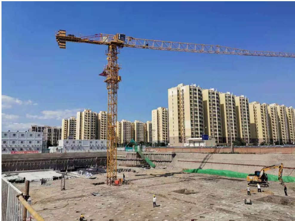
A 座教学楼、风雨操场-地基处理（CFG 桩施工）
