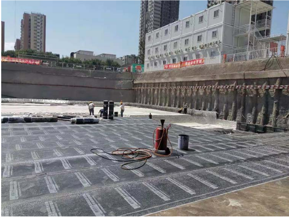
A 座教学楼、风雨操场-地下基础防水施工
