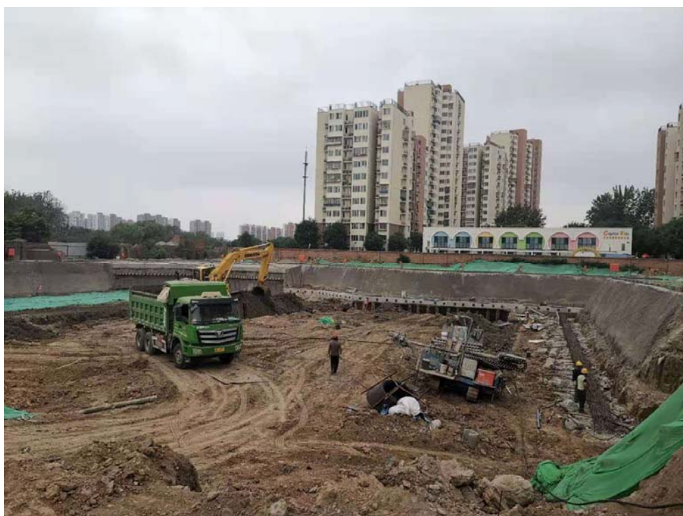
B 座教学楼基础土方开挖
