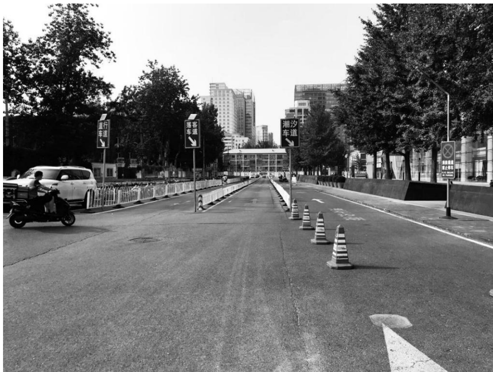
金桐路改造前照片
